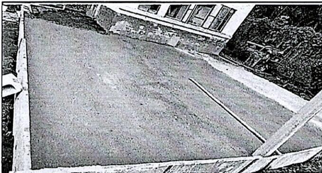
Foto 3: Reparación de piso de torta de concreto
