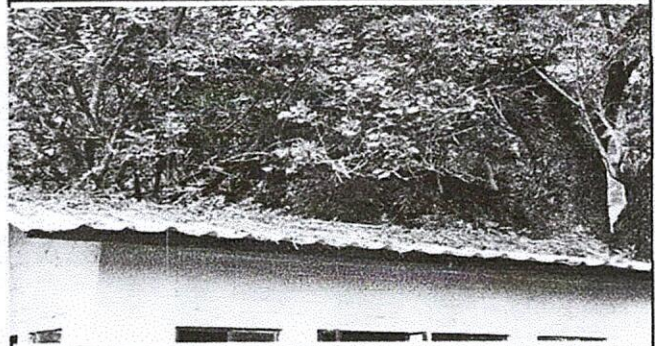
Foto 2: Sustrucción de cubierta de lámina
