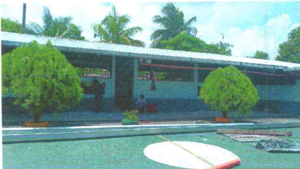
Foto 3: cambio de lamina
