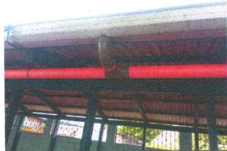
Foto 2: Mejoramiento de canales
