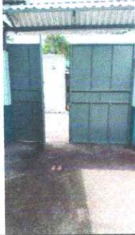
Foto 1: reparación de Porton principal
