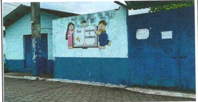
Foto: pintura exterior deteriorada
