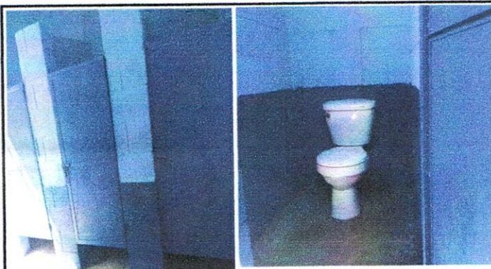
Foto 3: PUERTAS Y PINTURA INTERIOR Y EXTERIOR SANITARIOS TOTALMENTE REMOZADO Y FINALIZADO
