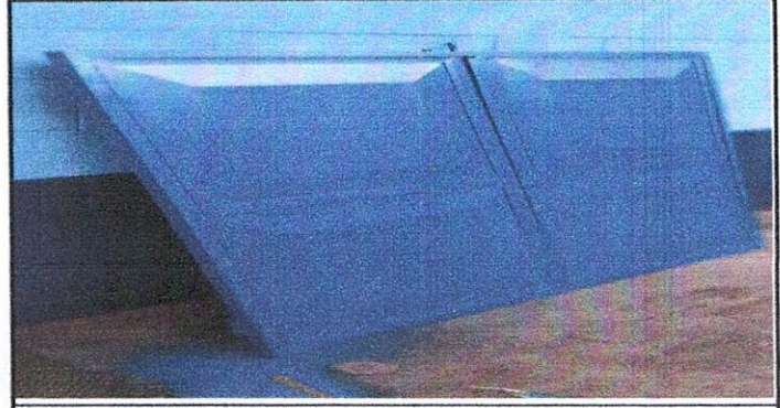
Foto 12: CONSTRUCCION DE VENTANAS PARA LA COCINA
