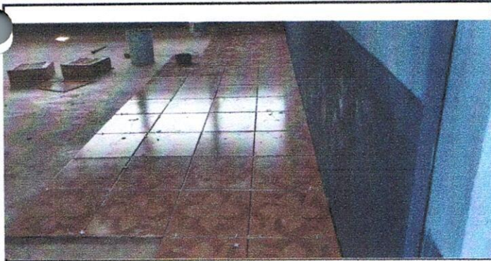
Foto 11: FASE DE INSTALACION DE PISO CERAMICO POR AULA TRABAJOS
