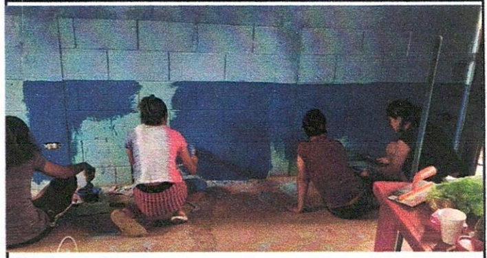
Foto 4: DURANTE EL PROCESO DE PINTADO DE LAS PAREDES INTERIOR Y EXTERIOR DE SALONES DE CLASES
