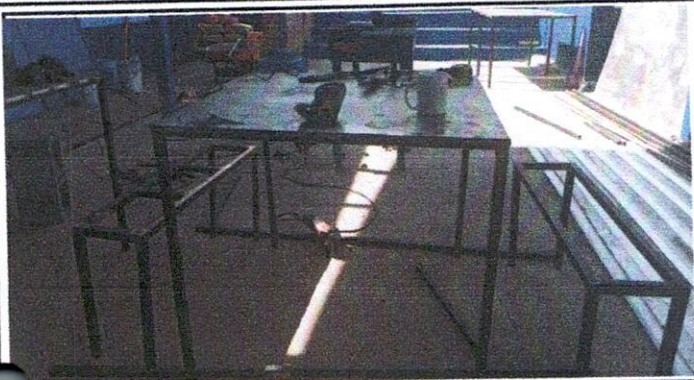
Foto7: CONSTRUCCION DE MESAS PARA EL COMEDOR DONDE LOS ALUMNOS PODRAN SENTAR A DEGUSTAR SUS ALIMENTOS Y CONSTRUCCION DE PUERTAS DE COCINAS ( FASE DURANTE)
