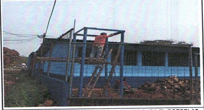
Foto 8: EN ESTA FASE SE CONSTRUYE LA TORRE PARA EL ROTOPLAS DE 1000LTS PARA ABASTECER AGUA AL PLANTEL EN GENERAL.
