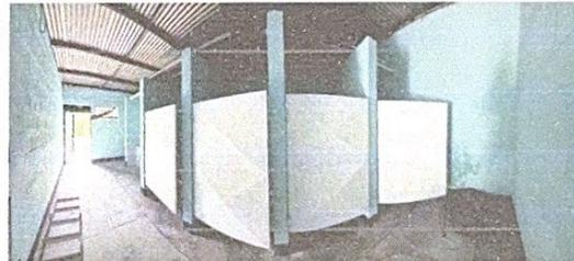
Foto 4: MANTENIMIENTO A PUERTAS, APLICACIÓN DE PINTURA EN MUROS
