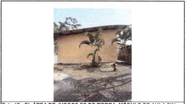
Foto 12: EL ÁREA DE JUEGOS ES DE TIERRA, MÓDULO DE AULA SIN CANAL Y SIN BAJADAS DE AGUA PLUVIAL
