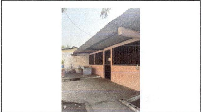
Foto 10: BALCONES DE VENTANAS CON OXIDO, PILA EN MALAS CONDICIONES
