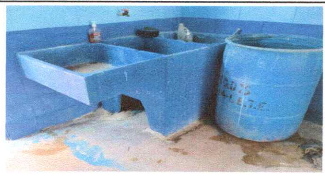
Foto5: MANO DE OBRA ESPECIALIZADA ALBAÑILERÍA. 19.20 Instalación de pila
