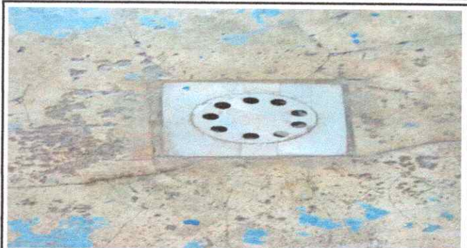
Foto2: REPARACIÓN DE RED DE DRENAJE Y RED DE AGUA POTABLE. Red de drenaje 14.1 Mantenimiento a reposaderas
