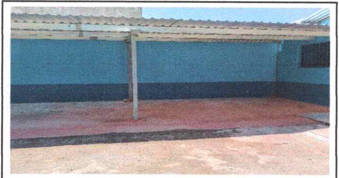
Foto4: SUSTITUCIÓN DE PISO. 6.5 Sustitución de piso de torta de concreto
