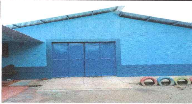
Foto1: MANTENIMIENTO A PORTONES. 12.1 Mantenimiento a portones de metal
