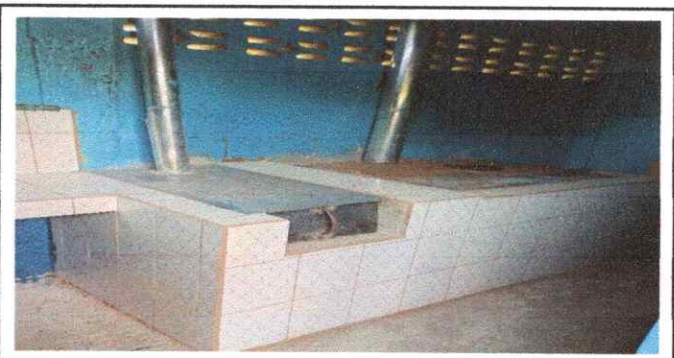
Foto6: REPARACIÓN DE COCINA. 20.2 Sustitución de estufa rural (completa) incluye chimenea y plancha de metal
