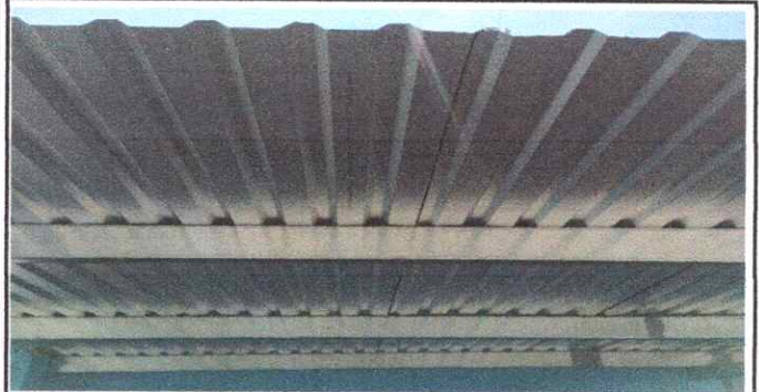
Foto 2: ESTRUCTURA DE TECHO. 2.3 Sustitución de estructura de soporte de metal por metal
