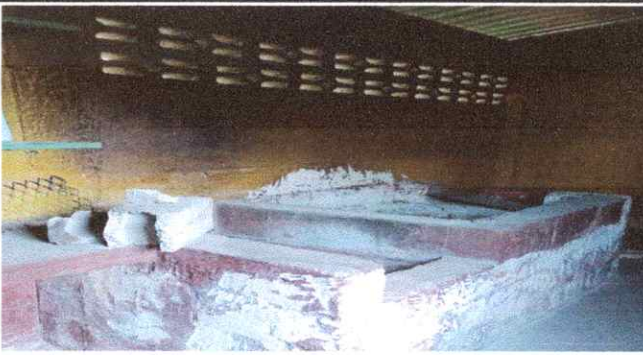
Foto6: REPARACIÓN DE COCINA. 20.2 Sustitución de estufa rural (completa) incluye chimenea y plancha de metal
