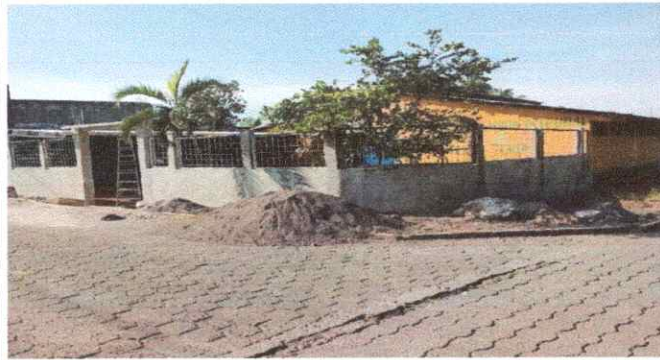
Foto1: REPARACIÓN DE REPELLO Y CERNIDO DE PAREDES 21.1 Reélo en muro 21.2 Cernido en muro
