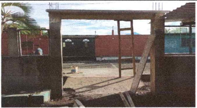
Foto3: MUROS PERIMETRALES. 15.2 Reparación de muro perimetral de block con tubo hg y malla galvanizada, soleras intermedias y columnas
