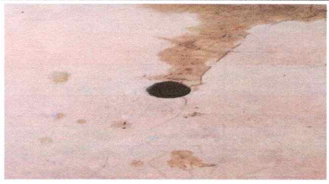
Foto2: REPARACIÓN DE RED DE DRENAJE Y RED DE AGUA POTABLE. Red de drenaje 14.1 Mantenimiento a reposaderas
