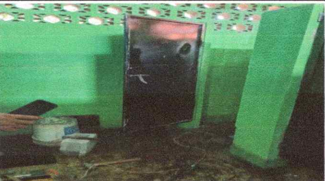
Foto3: PUERTAS DE METAL. 4.4 Sustitución de puertas en servicios sanitarios.
