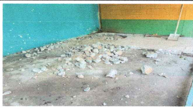
Foto4: SUSTITUCIÓN DE PISO. 6.5 Sustitución de piso de torta de concreto
