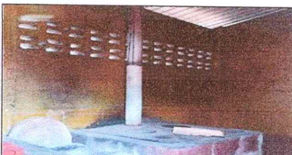
Foto 6: REPARACION DE COCINA. 20.2. Sustitución de estufa rural (completa) incluye chimenea y plancha de metal.
