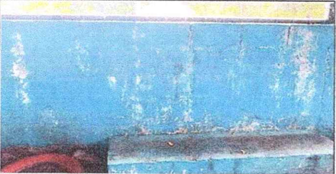
Foto 5: PINTURA EN MUROS EXTERIORES E INTERIORES 9.1. Pintura en muros exteriores e interiores.
