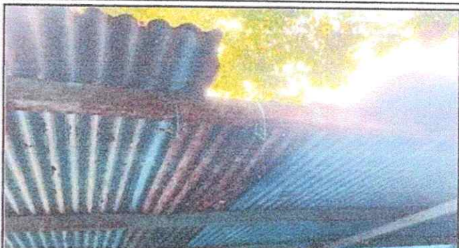
Foto 2: ESTRUCTURA DE TECHO 2.3 Sustitución de estructura de soporte de metal por metal
