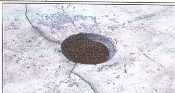
Foto 2: REPARACION DE RED DE DRENAJE Y RED DE AGUA POTABLE. Red de Drenaje 14.1. Mantenimiento a reposaderas.
