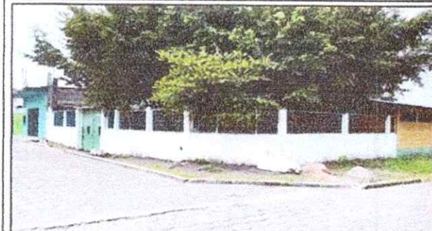
Foto1: REPARACIÓN DE REPELLO Y CERNIDO DE PAREDES 21.1 Repello en muro 21.2 Cernido en muros
