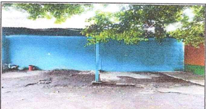
Foto 4: SUSTITUCION DE PISO. 6.5. Sustitución de piso de torta de concreto.
