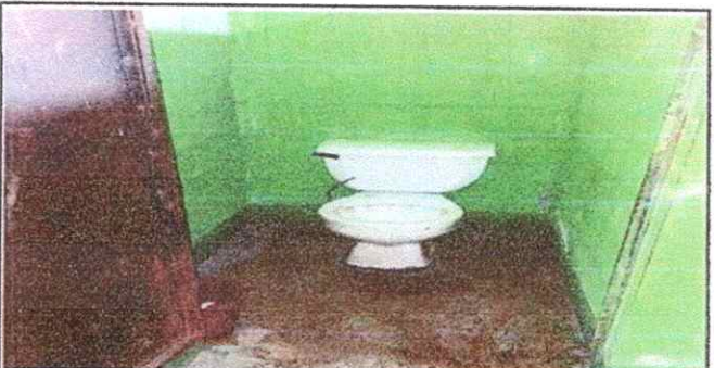
Foto 6: SERVICIOS SANITARIOS Y SUS ACCESORIOS 10.3 Sustitución inodoro.
