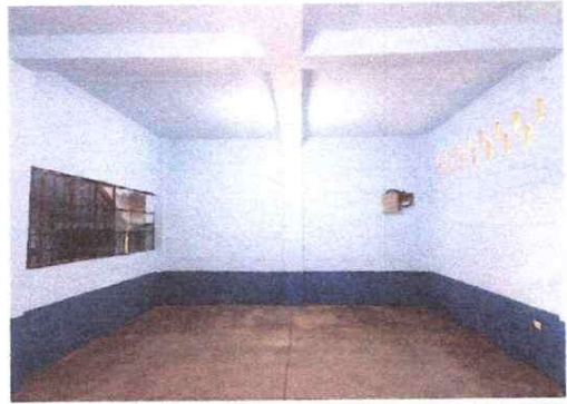
Foto 2: Pintura en muros interiores
