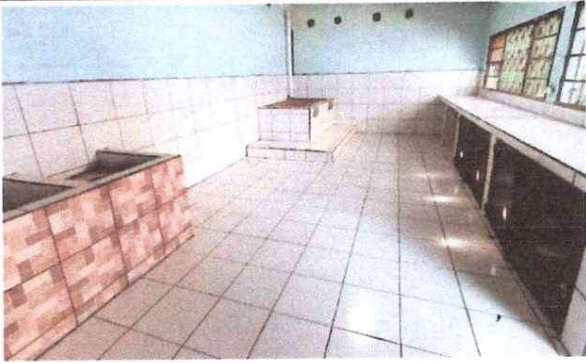
Foto 1: Sustrucción de piso cerámico en la cocina
