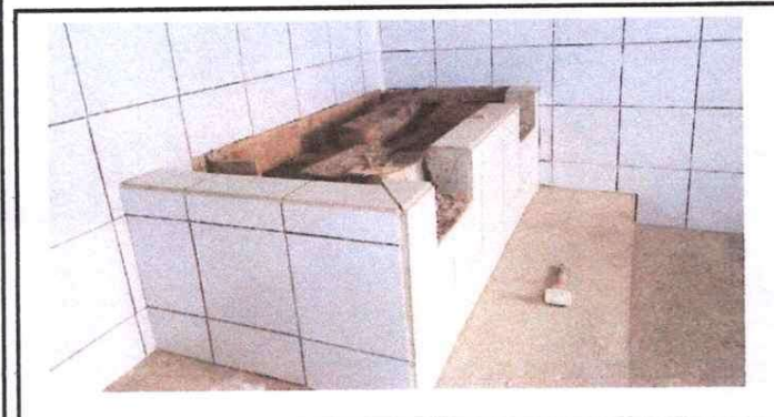
Foto 9: Instalación de azulejo en estufa rural
