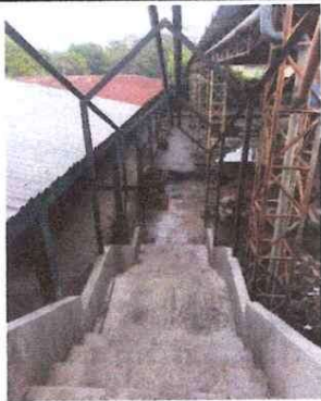
Foto 3: Sustrucción de baranda de metal; debido a que están en mal estado y resbalosos y cuando llueve los estudiantes se resbalan y ocasionado accidentes.
