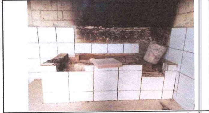
Foto 8: Sustitución de estufa rural (completo) incluye chimenea y plancha de metal; debido a que la actual está en mal estado y ocasiona problemas a la hora de preparar los alimentos de los niños
