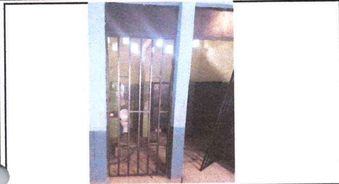
Foto 7: Fabricación e instalación de puertas de rejas en baños de varones
