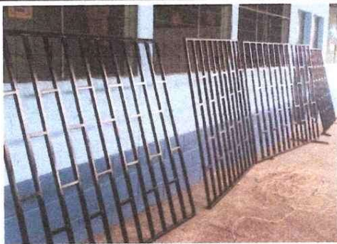
Foto 5: Fabricación e instalación de balcones en hierro en ventana en los salones del segundo nivel
