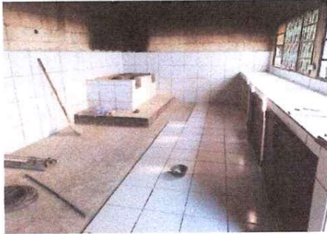
Foto 1: Sustrucción de piso cerámico en la cocina
