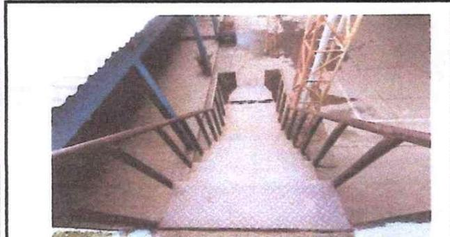
Foto 3: Sustrucción de baranda de metal; debido a que están en mal estado y resbalosos y cuando llueve los estudiantes se resbalan y a ocasionado accidentes.
