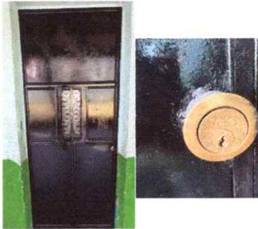
Foto 3: finalización de remozamiento en mantenimiento a estructura de 12 puertas y sustitución de 5 chapas
