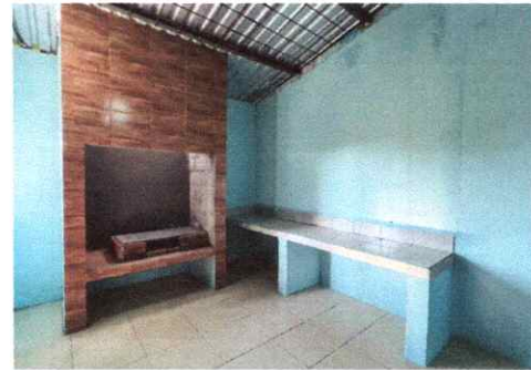
Foto 4: finalización de sustitución de estufa rural completa, con chimenea y plancha de metal, y reparación de azulejo en muebles de cocina
