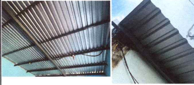
Foto1: finalización de sustitución de lamina troquelada aluzinc calibre 26, sustitución de capote, sustitucion de elementos de fijacion, mantenimiento de estructura de soporte de metal de 8 salones y sustitucion de estructura de metal
