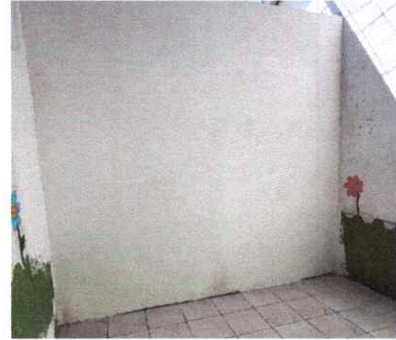
Foto 2: finalización reparación de muro de block, repello y cernido de pared
