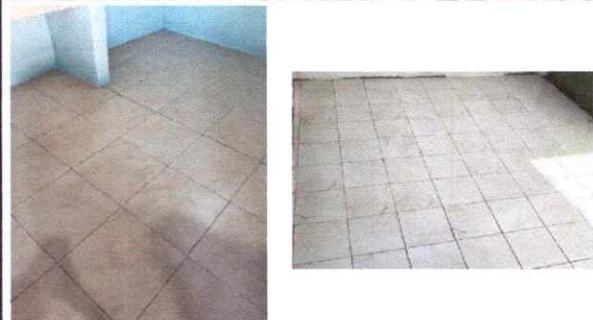
Foto 6: finalización de cambio de piso a cocina y direccion
