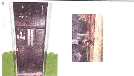
Foto 3: inicia el mantenimiento de puertas y cambio de chapas
