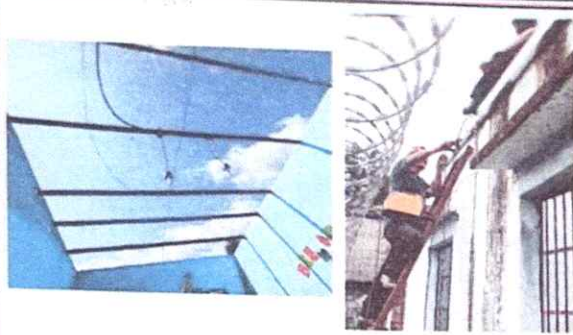
Foto1: inicia el cambio de lamina troquela, mantenimiento de estructura de soporte de metal y cambio de estructura de metal por metal
