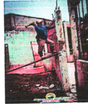
Foto 2: Quitando techado y vigas que para reforzarlas.
