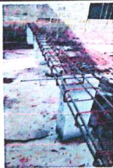
Foto 5: Realizando estructura para columna.
