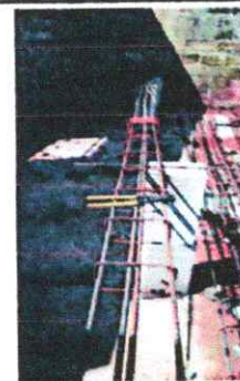
Foto 6: Empezando a trabajar en la estructura de columna.
