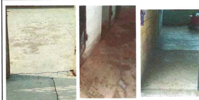
Foto 6: Reparación de piso en una aula.
