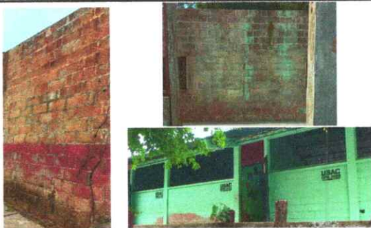
Foto 5: Reparación de paredes y columnas.
