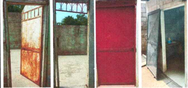
Foto 2: Reparación de puertas y marcos de 8 salones de clase
