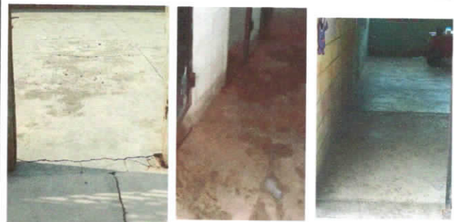
Foto 6: Reparación de piso en una aula.
