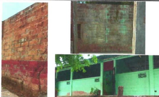
Foto 5: Reparación de paredes y columnas.
