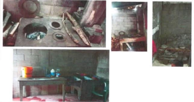
Foto 4: Reparación de polletones, chimenea y cambio de pilas
