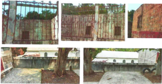
Foto 3: Reparación de balcones y colocación de barandal para el reguardo de los estudiantes.
