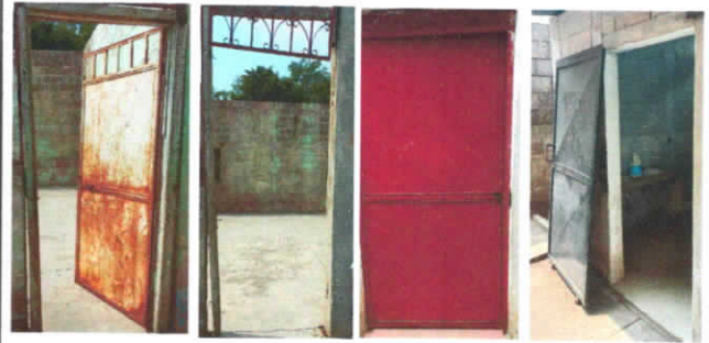
Foto 2: Reparación de puertas y marcos de 8 salones de clase
