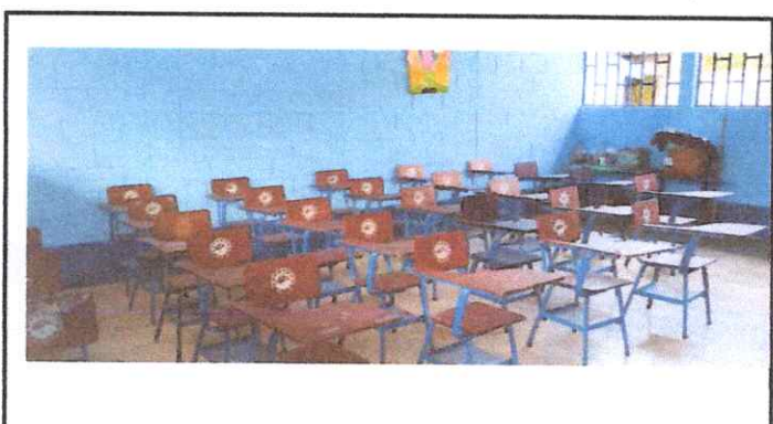
Foto 4: IMPERMEALIZACION DE LOSA 3.1. Pintar todas las aulas.
