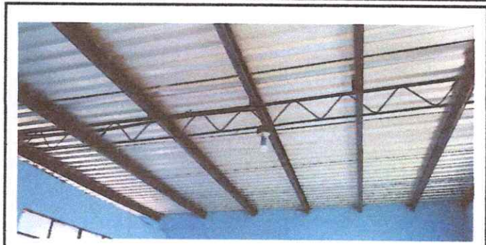
Foto 2: ESTRUCTURA DE TECHO 2.1. Mantenimiento a estructura de soporte de metal.
