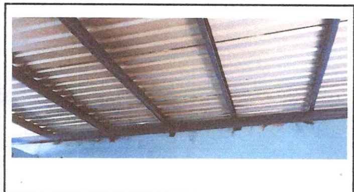
Foto 3: ESTRUCTURA DE TECHO 2.2. Sustitucion de estructura de madera por metal.
