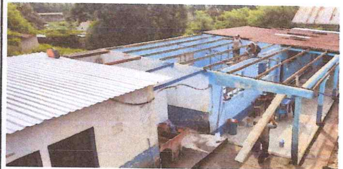
FOTO 10 MANO DE OBRA ESPECIALIZADA ALBAÑILERIA, HERRERÍA, ELECTRICIDAD Y PLOMERÍA 19.8 Instalación de lámina troquelada aluzin calibre 26
