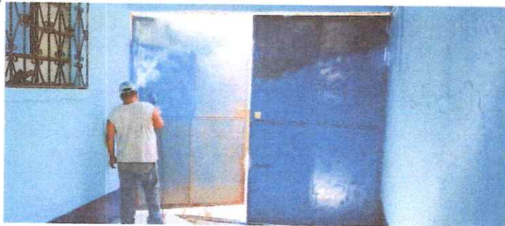
FOTO 11 MANTENIMIENTO A PORTONES 12.1. Mantenimiento a portones
