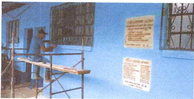
Foto 5: VENTANAS 5.7. Mantenimiento a balcones de metal
