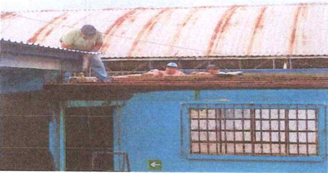
Foto 3: ESTRUCTURA DE TECHO 2.2. Sustitucion de estructura de madera, por metal
