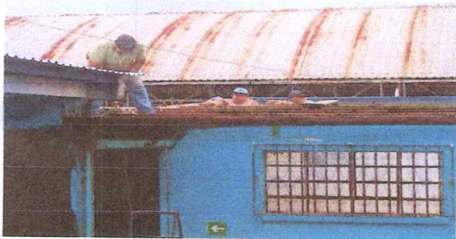
FOTO 9. ESTRUCTURA DE TECHO 2.3. Sustitucion de estructura de soporte de metal por metal.
