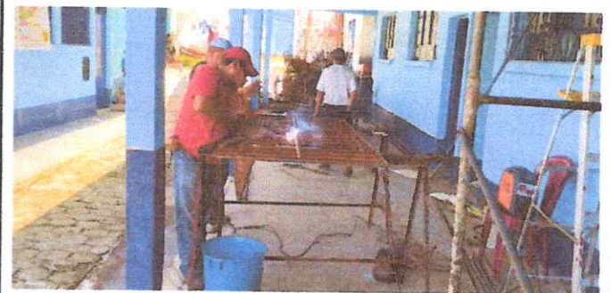
Foto 6: MANO DE OBRA ESPECIALIZADA HERRERÍA 19.2. Fabricacion e instalación de balcones de hierro en ventana
