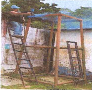
FOTO 7. REPARACIÓN Y MANTENIMIENTO DE CISTERNAS/ DEPOSITOS DE AGUA 18.2. Sustitución de depósitos de agua 1100 litros
