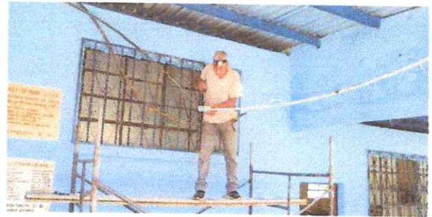
FOTO 8. REPARACION DE SISTEMA ELECTRICO 17.4 susticion de focos ahorradores 17.8. sustitucion de tomacorriente dobles 17.9. sustitucion de filipones 17.11. reparacion de cableado electrico
