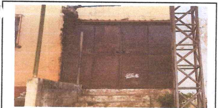
Foto 5: MANTENIMIENTO A PORTONES 12.1 Mantenimiento a portones de metal
