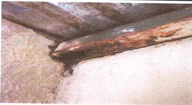
Foto 11: ESTRUCTURA DE TECHO 2.3 Sustitución de estructura de soporte de metal, por metal
