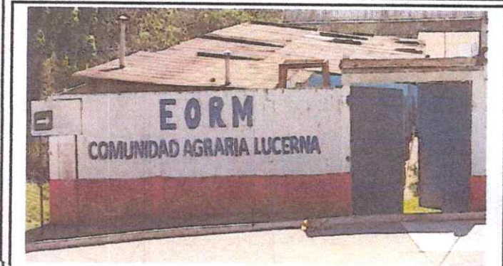
Foto1: CUBIERTA DE LÁMINA 1.1: Sustitución de lámina, por lámina troquelada alizin calibre 26
