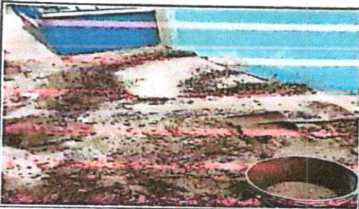
16.1 Reparación de plancha de concreto de patio
