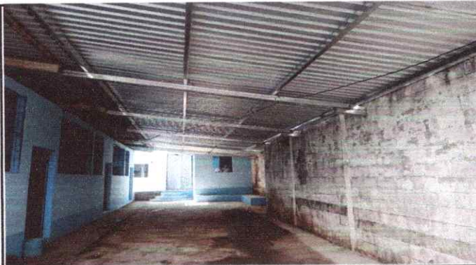
Foto 3: TECHADO AREA DE COMEDOR
