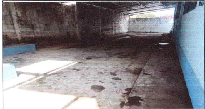
Foto 4: PAVIMENTACION AREA DE COMEDOR
