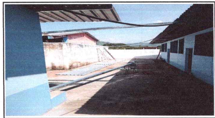
Foto 4: PAVIMENTACION DE PATIO
