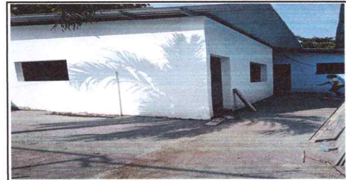
Foto 6: PAVIMENTACION DE PATIO DEL LADO DE LA ENTRADA Y COCINA
