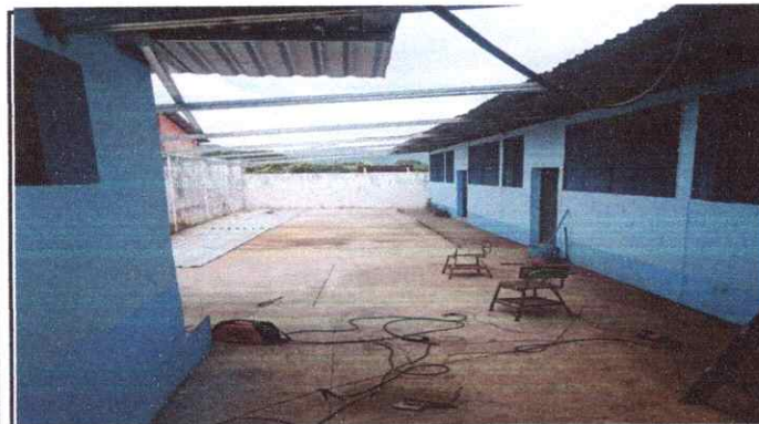
Foto : AREA DONDE SERA EL TECHADO DE COMEDOR
