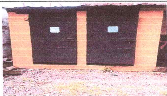
Foto 10: SERVICIOS SANITARIOS Y SUS ACCESORIOS 10.1 Mantenimiento a estructura a puertas de servicios de Sanitarios (lijado, cambio de tubo, cepillado, sugeciones, aplicación de pintura
