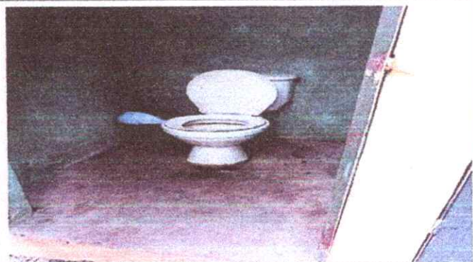
Foto 8: SERVICIOS SANITARIOS Y SUS ACCESORIOS 10. 3 Sustitución Inodoro
