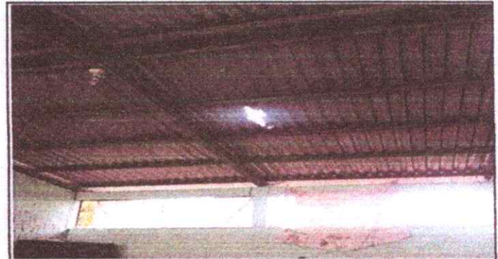
Foto 6: CUBIERTA DE LAMINA 1.1 Sustrucción de lámina, por lámina Troquelada aluzinc calibre 26
