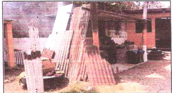
Foto 4: MUROS PERIMETRALES 15.1 Reparación de muro perimetral de block
