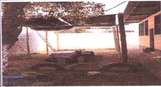
Foto 1: CUBIERTA DE LAMINA 1.1: Sustrucción de techo por techo de lámina troquelada aluzinc calibre 26 al techo de comedor
