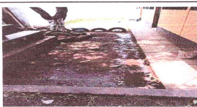
Foto 11: PISO 6.5 Sustitución de Piso de Torta de concreto
