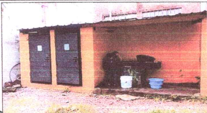
Foto 7: SERVICIOS SANITARIOS Y SUS ACCESORIOS 10.5 Sustitución de Lavamanos
