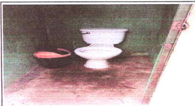
Foto 9: SUSTITUCIÓN DE AZULEJO 13.1 Sustitucion de Azulejo
