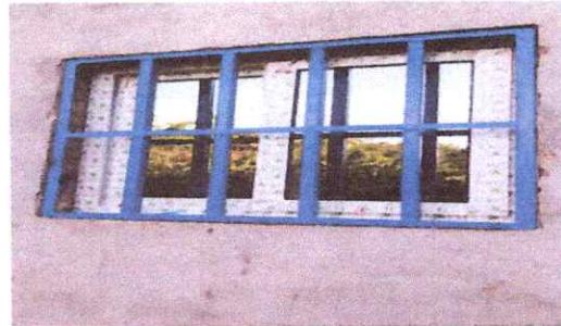
Foto 4: 2.3 finalizacion de ventana-balcon+pvc
