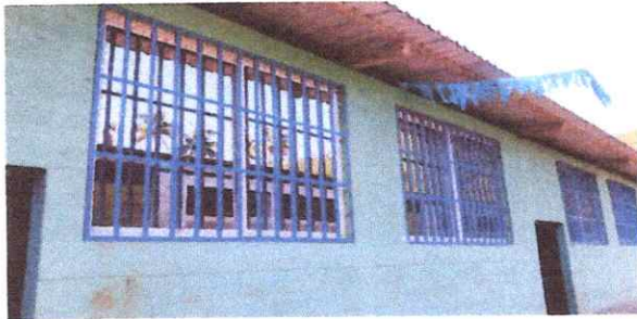
Foto 3: 2.3 finalizacion de ventana-balcon+pvc.
