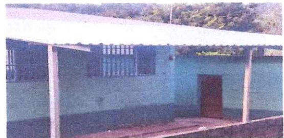
Foto 6: finalizacion de estructura de metal y techado.
