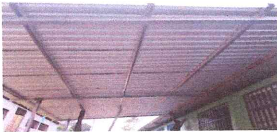
Foto 5: 2.3 finalizacion de techado.
