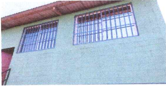
Foto1: 1.1 finalizacion ventana-balcon+pvc de lado izquierdo.
