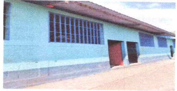
Foto 2: 2.3 instalacion de ventanas- balcon.
