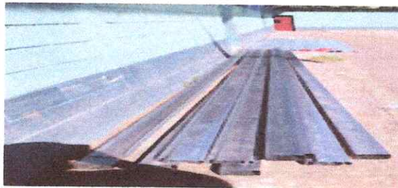
Foto 5: 2.3 materal de estructura de metal.
