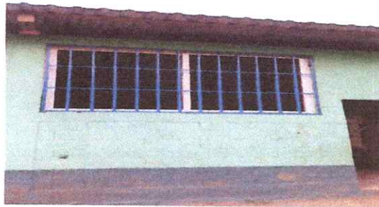
Foto 3: 2.3 instalacion de ventana-balcon+ PVC
