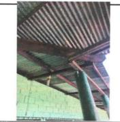
Canal en mal estado por corrosión, se necesita la reparación también de costaneras realizar lijado y pintado.
