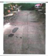
Se observa el piso de torta de cemento dañado, se necesita realizar un cambio en el piso de cemento por piso de cerámica.
