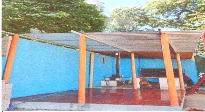
FOTO 1: 1 Cubierta de lámina
