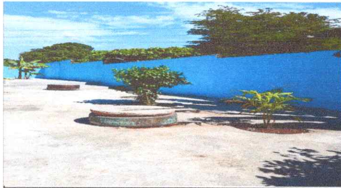
FOTO 3: 9. Pinturas en muros exteriores e interiores
