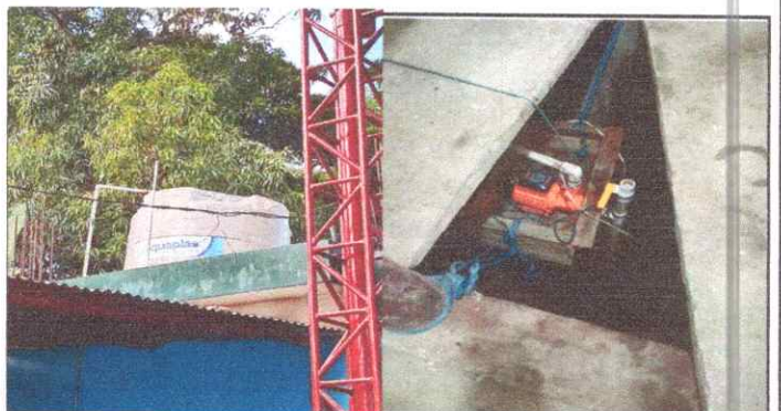
FOTO 6: 18. Reparación y mantenimiento de cisternas/depositos de agua
