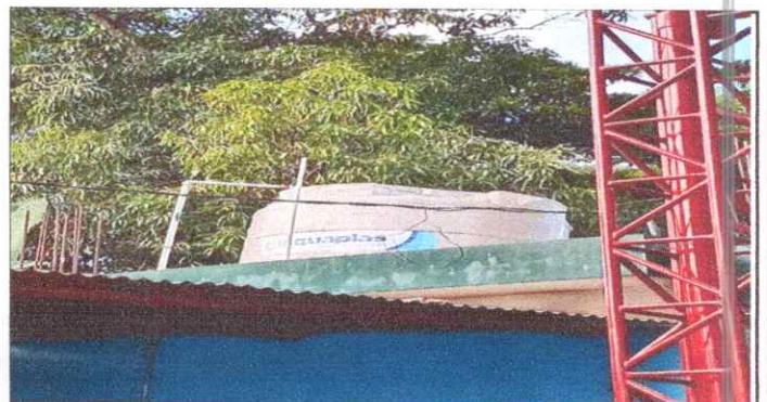
FOTO 6: 18.3 Sustrucción de deposito de agua 1700 It
