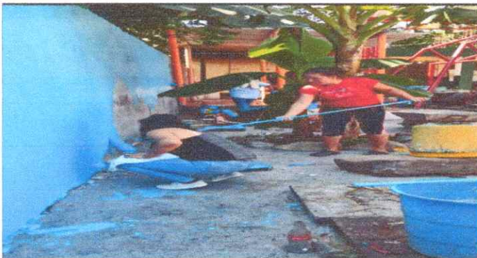
FOTO 3: 9.1 Pintura en muros exteriores e interiores
