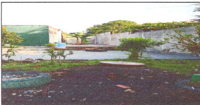
FOTO 5: 16.1 Reparación de planchas de concreto de patio
