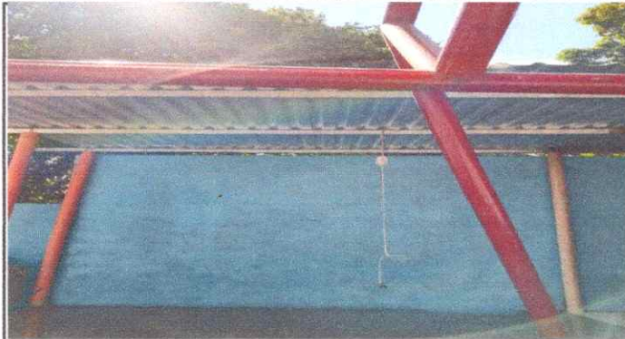
FOTO 1: 1.1 Sustrucción de lámina, por lámina troquelada aluzinc calibre 26
