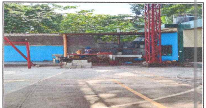
FOTO 4: 15.1 Reparación de muro perimetral de block
