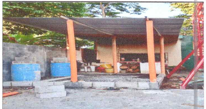
FOTO 2: 6.5 Sustrucción de piso de torta de concreto
