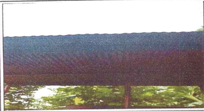
FOTO 1: cubierta de lámina
