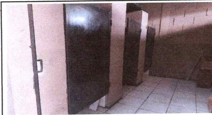
Foto 3: 4.3 sustitución de puertas
