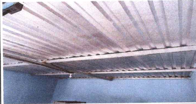
Foto 1: 1.1 sustitución de lamina troquelada aluxinc calibre 16 1.3 sustitución de elementos de fijación 2.1 sustitución a estructura de soporte de metal
