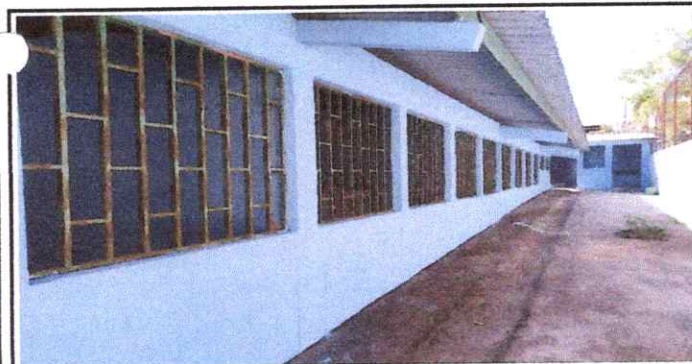
Foto 5: 9.1 pintura en muros exteriores e interiores
