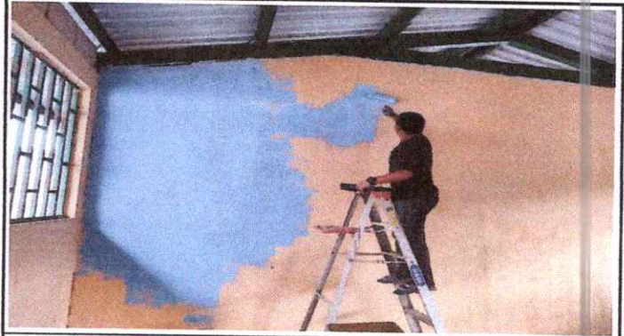
Foto 8: 9.1 pintura en muros exteriores e interiores
