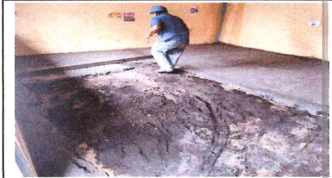
Foto 6: 6.5 Sustitución de piso de torta de concreto 6.6 Sustitucion de piso de torta de cemento liquido
