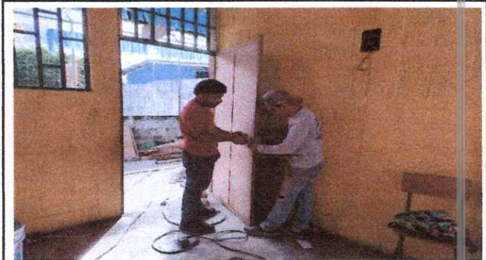
Foto 4: 4.2 sustitución de chapa
