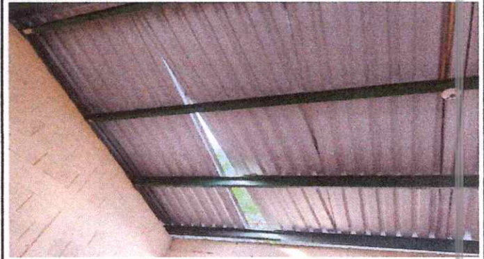
Foto 2: 2.1 sustitución de estructura de soporte de madera por metal
