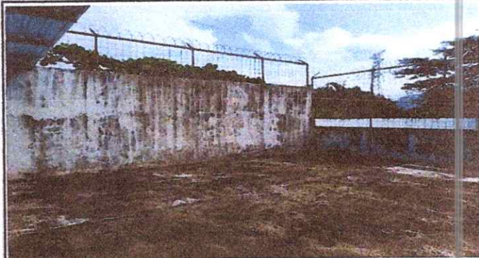
Foto 8: 9.1 Pintura en muros exteriores e interiores
