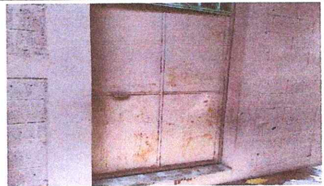
Foto 4: 4.2 sustitución de chapa
