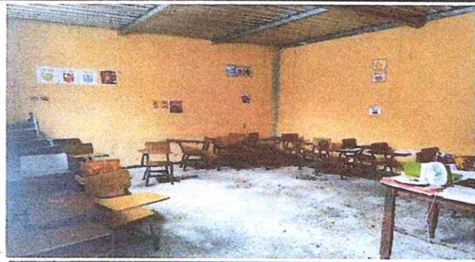
Foto 13: 1.1 repello en muro 21.2 cernido en muro
