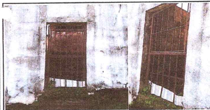
Foto 5: sustitucion de puertas en servicio sanitarios,
