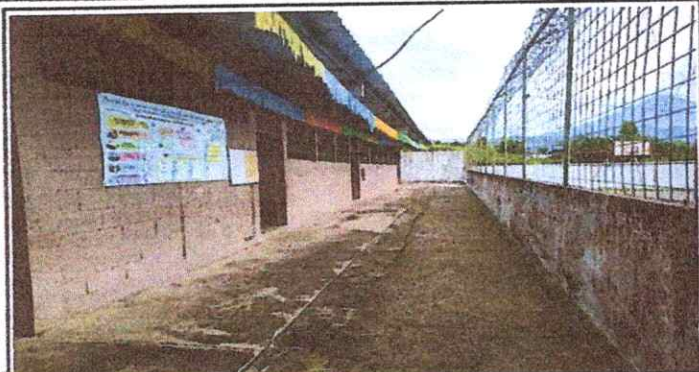
Foto 7: 9.1 Pintura en muros exteriores e interiores
