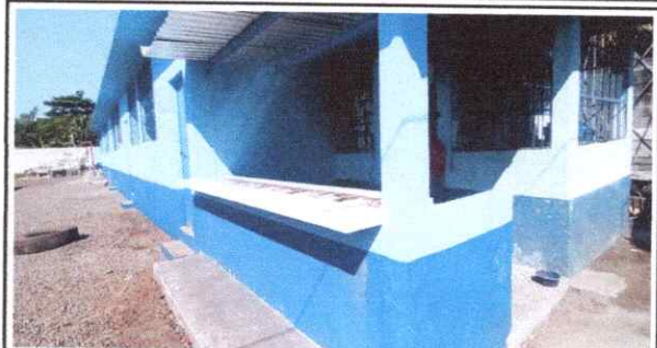
FOTO 2: Sustitución de estructura de soporte de madera, por metal. En el area de cocina.
