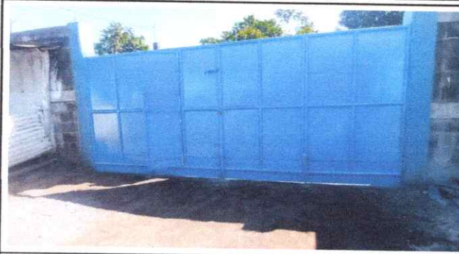
FOTO 7: Mantenimiento a portones de metal.
