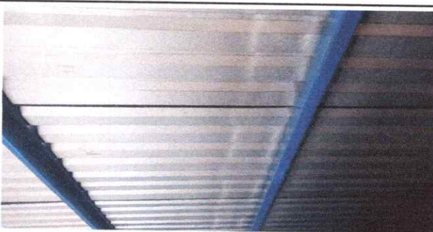
Foto 11: SUSTITUCION DE TRES LAMINAS EN LA DIRECCION
