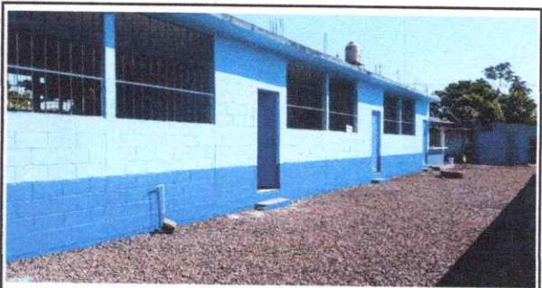
FOTO 4: Pintura en muros de interiores y exteriores.
