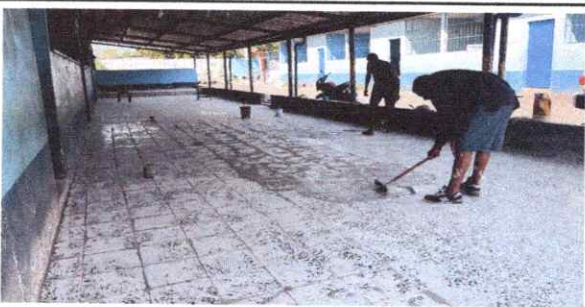
FOTO 5: Sustitución de piso de torta de concreto. En el area del corredor
