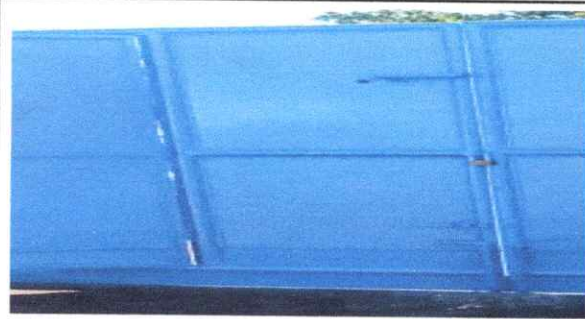
FOTO 3: Mantenimiento a estructura (lijado, cambio de tubo , cepillado, sujeciones, aplicación de pintura). En dos puertas de los salones de clases.
