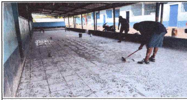
FOTO 5: Sustitución de piso de torta de concreto. En el area del corredor
