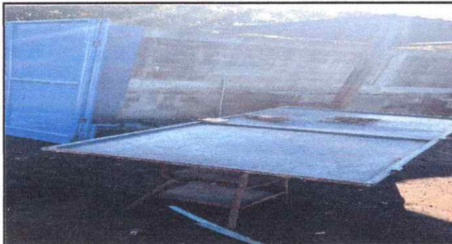
FOTO 3: Mantenimiento a estructura (lijado, cambio de tubo , cepillado, sujetones, aplicación de pintura). En dos puertas de los salones de clases.
