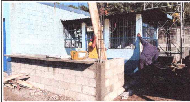
FOTO 1: Sustitución de lámina, por lámina troquelada aluzinc calibre 26. En el area de cocina.
