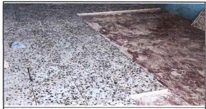
FOTO 6: Sustitucion de piso de granito en el area de cocina.
