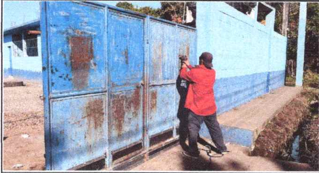
FOTO 7: Mantenimiento a portones de metal.
