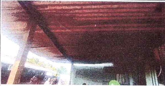
FOTO 1: Sustitución de lámina, por lámina troquelada aluzinc calibre 26. En el area de cocina.
