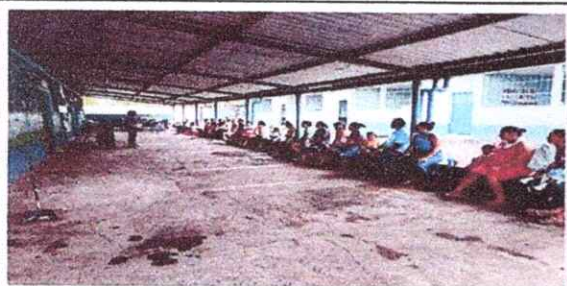
FOTO 5: Sustitución de piso de torta de concreto. En el area del corredor
