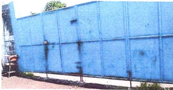
FOTO 7: Mantenimiento a portones de metal.
