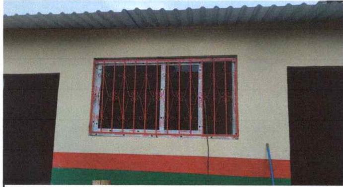
Foto1: Remozamiento de Balcon en ventanas de la cocina y cuerda de lamina , puerta de metal, pintura en exteriores e interiores .
