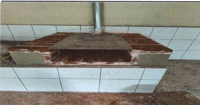
Foto 3: Remozamiento se realizo 2 chimenea de la cocina
