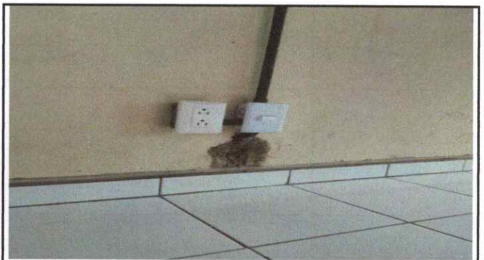
Foto 4: Remozamiento reparacion de electecidad del uso de la cocina .
