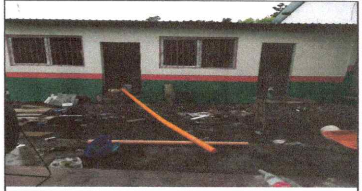
Foto 2: Remozamiento extra se limpio del pozo de la cocina que sera de utilidad, y se cancelo la limpieza del pozo los albañiles
