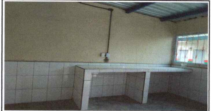
Foto 2: Remozamiento mantenimiento de piso ceramico ,reparcion de piso de concreto .
