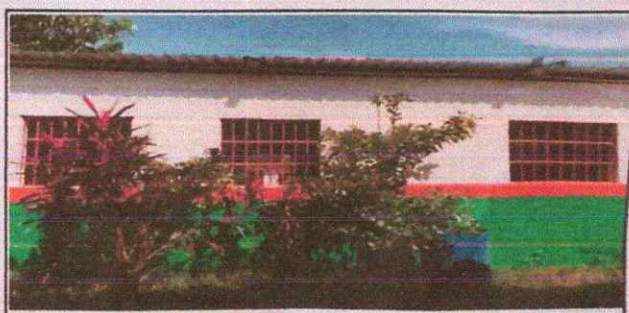
Foto 6: Remozamiento de Balcon en aulas.
