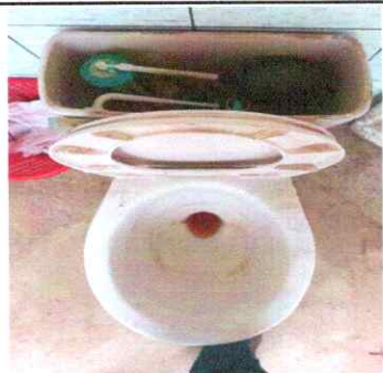
Foto No. 5 Remozamiento de accesorios de tanque de inodoro.
