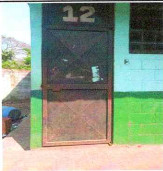
Foto 3. Remozamiento de Puerta de Aula No. 12
