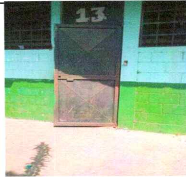
Foto 4. Remozamiento de Puerta de Aula No. 13
