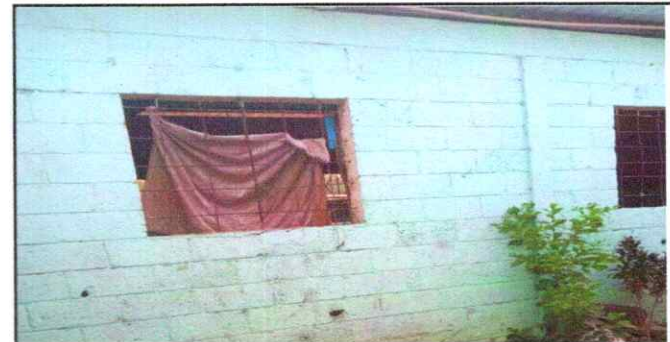
Foto Remozamiento de Balcon en aulas.
