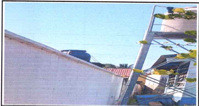
Foto 6: Tubería de tanque y baños reparadas
