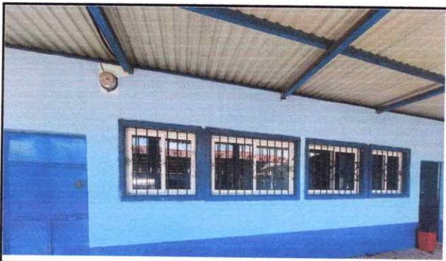
Foto 17: Mantenimiento de balcones de metal.
