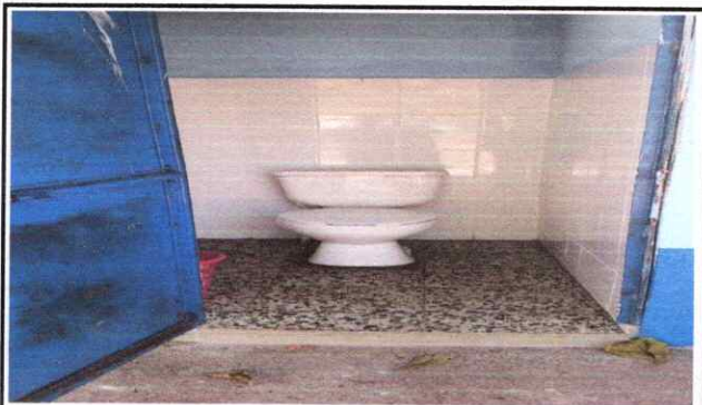
Foto 5: Servicios sanitarios y sus accesorios reparados
