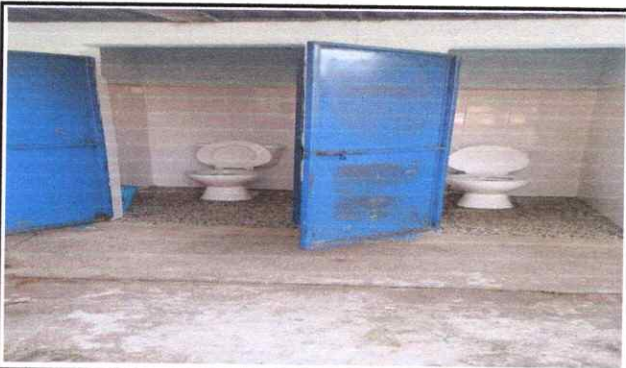
Foto 5: Reparaion de servicios sanitarios.
