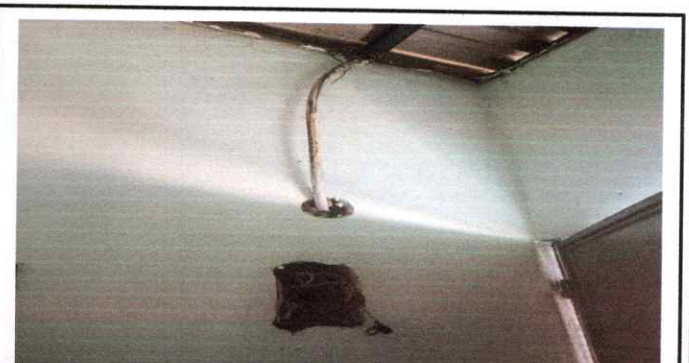
Foto 10: Reparación de caja electrica en mal estado y cableado electrico de dicha aula.
