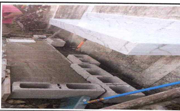
Foto 11: Sustitución de pila de cemento de dos lavaderos.
