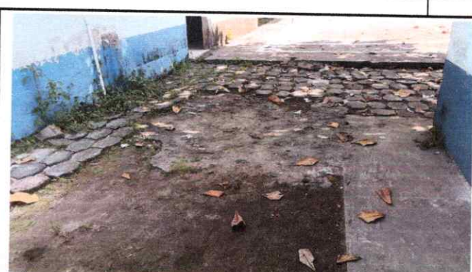
Foto 14: Reparación de piso de torta de concreto, que está en mal estado.
