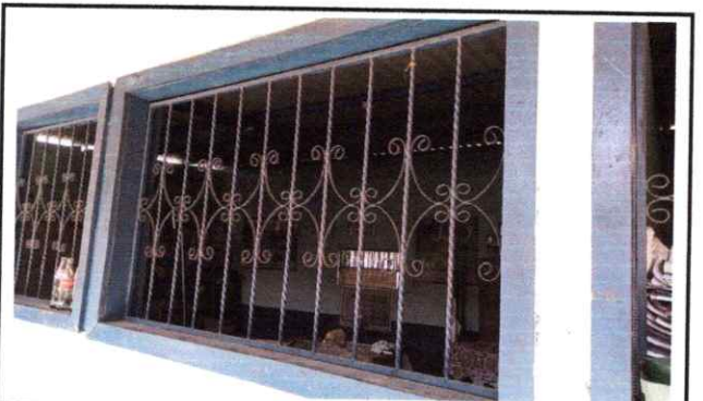
Foto 17: Mantenimiento de balcones de metal.
