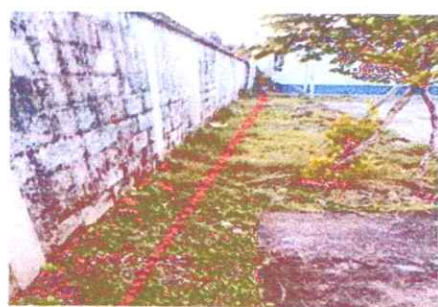
Foto 6: Reparación de tubería de tanque y baños.
