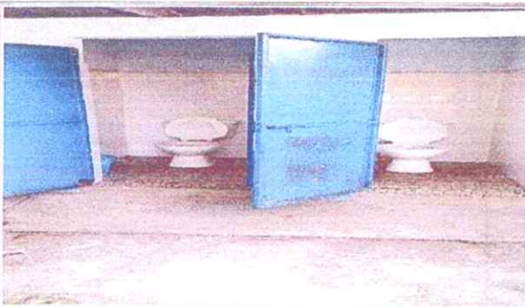
Foto 5: Reparación de servicios sanitarios.
