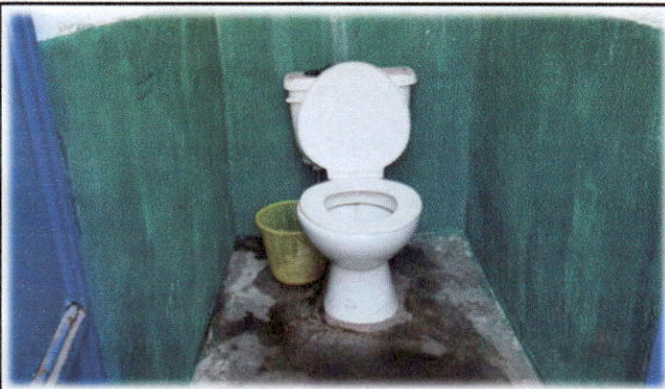
Foto 3: Reparación y mejoramiento de servicios sanitarios, incluye reparaciones, cambio de tubería, artefactos y muebles fijos de concreto (migratorio y pileta) y azulejo.
