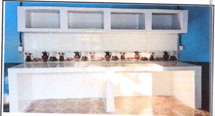
Foto 10: Instalacion de Azulejo en muebles de concreto en cocina
