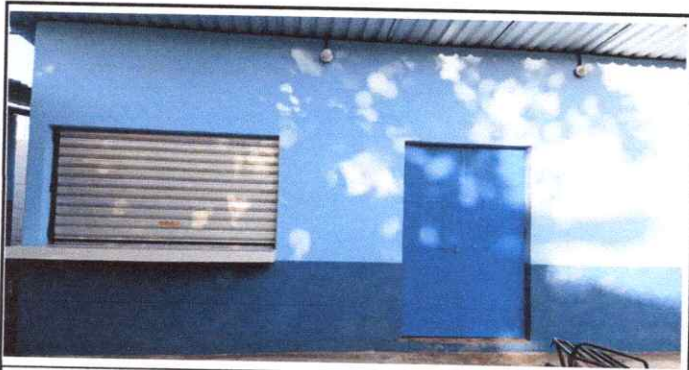
Foto 11: Aplicación de Repello en paredes de cocina
