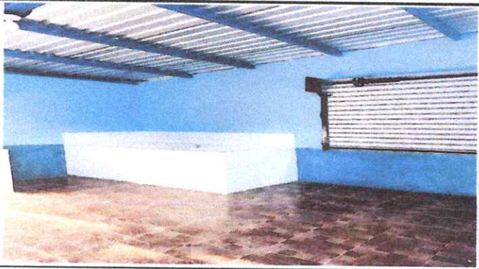
Foto 3: Sustitución de Torta de piso de concreto del modulo de cocina
