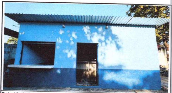
Foto 12: Aplicación de Repello en paredes de cocina
