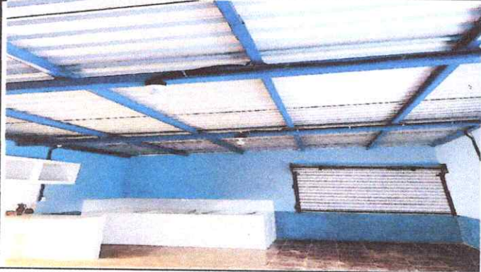
Foto 1: Sustitución de lamina por lamina troquelada de aluzinc calibre 26 en modulo de cocina
