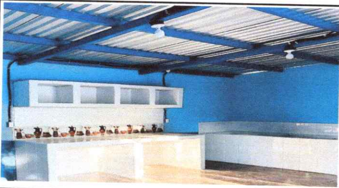
Foto 9: Instalacion de Azulejo en Estufa Rural
