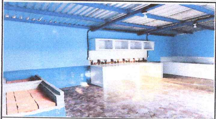
Foto 2: Sustitución de soporte de metal por metal en modulo de cocina
