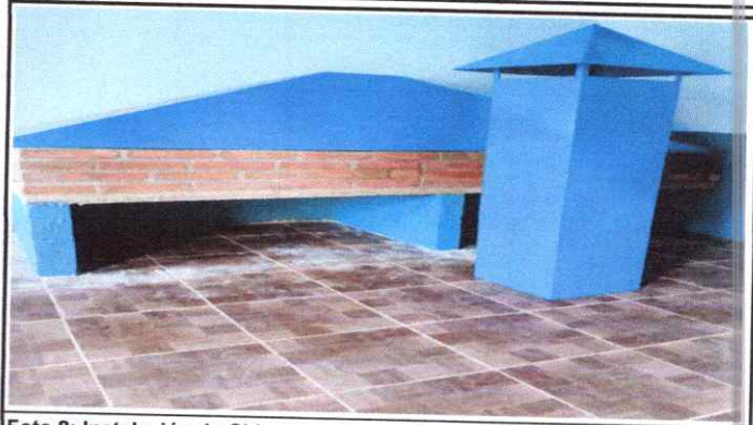
Foto 8: Instalación de Chimenea de metal.
