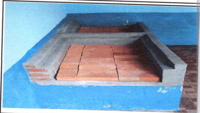
Foto 8: Instalacion de Chimenea de concreto
