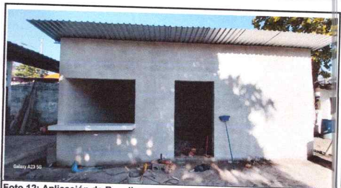
Foto 12: Aplicación de Repello en paredes de cocina
