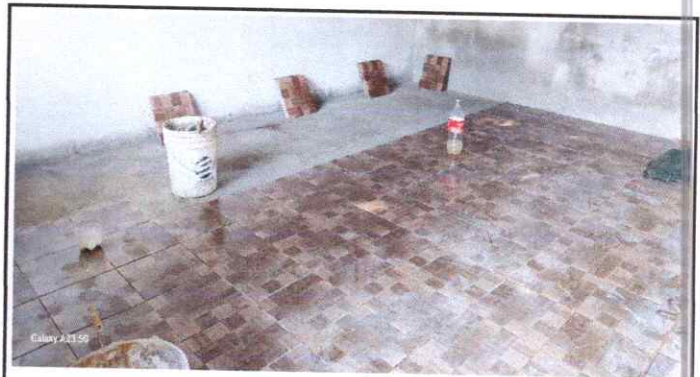
Foto 4: Instalacion de Piso Ceramico en Modulo de Cocina
