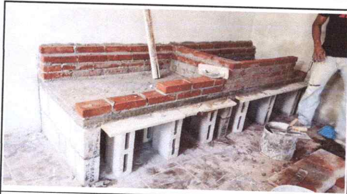
Foto 9: Instalacion de Azulejo en Estufa Rural
