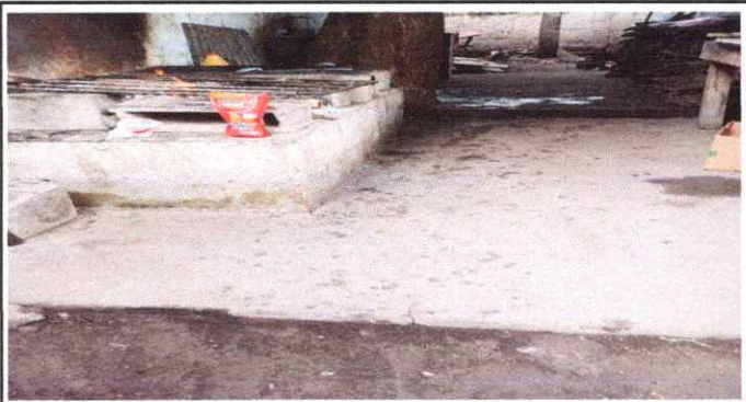
Foto 3: Sustrucción de Torta de piso de concreto del modulo de cocina
