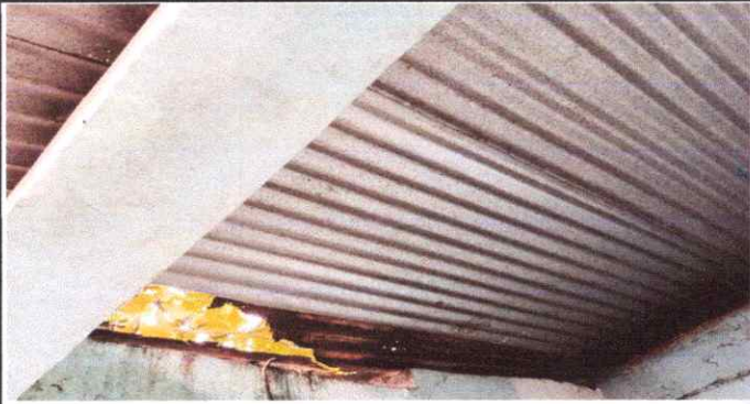
Foto 1: Sustrucción de lamina por lamina troquelada de aluzinc calibre 26 en modulo de cocina
