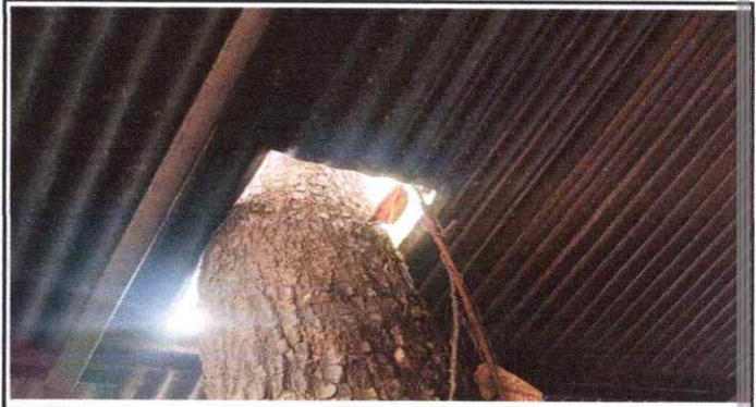
Foto 8: Instalacion de Chimenea de concreto
