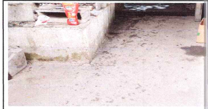
Foto 4: Instalacion de Piso Ceramico en Modulo de Cocina
