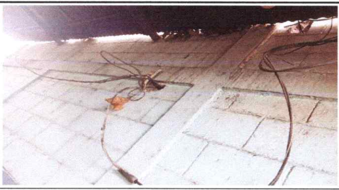
Foto 11: Aplicación de Repello en paredes de cocina
