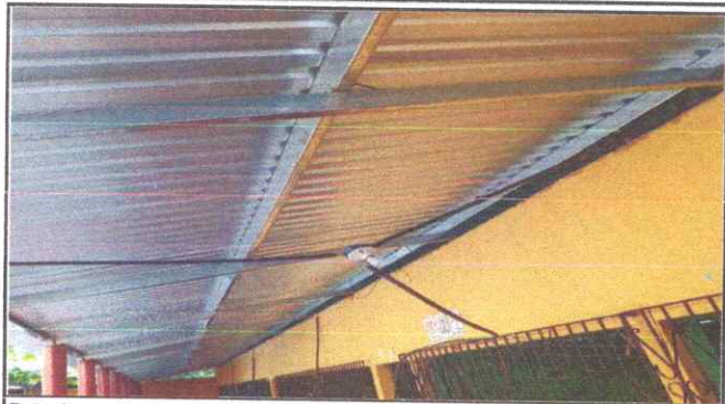
Foto 1: sustitucion de madera por metal y sustitucion de laminas del corredor
