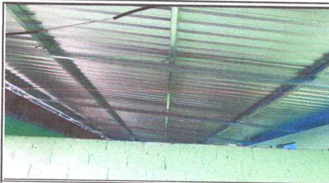
Foto 2: sustitucion de lámina y sustitucion de estructura de soporte de madera por metal de las cuatro aulas
