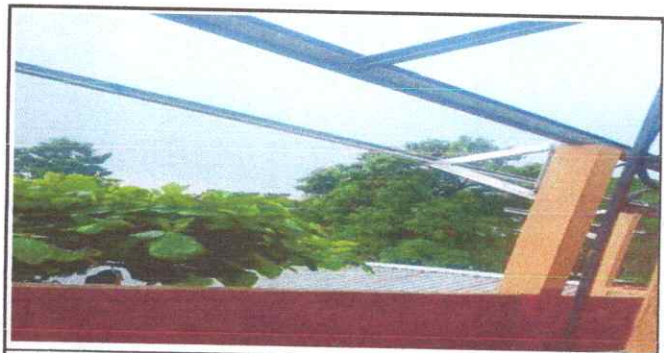
Foto 6: sustitucion de lamina troquelada.
