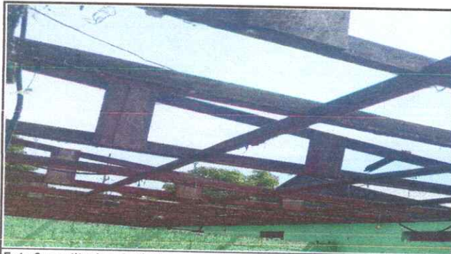
Foto 3: sustitucion de lámina y sustitucion de estructura de soporte de madera por metal de la cocina
