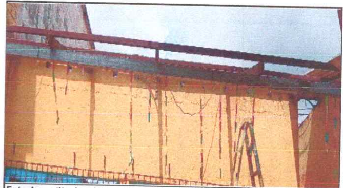
Foto 4: sustitucion de soporte de madera y metal en mal estado a metal y sustitucion laminas troqueladas mas agredo de pestaña
