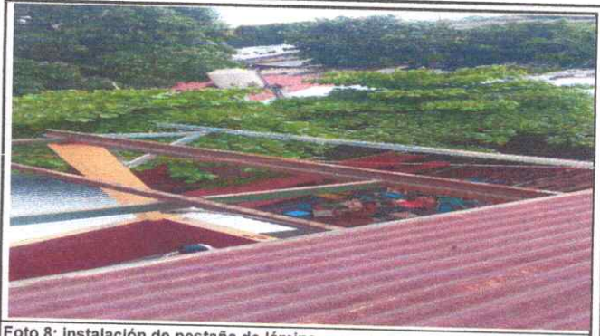
Foto 8: instalación de pestaña de lámina
