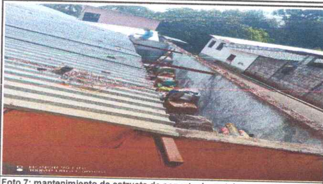
Foto 7: mantenimiento de estructura de soporte de metal
